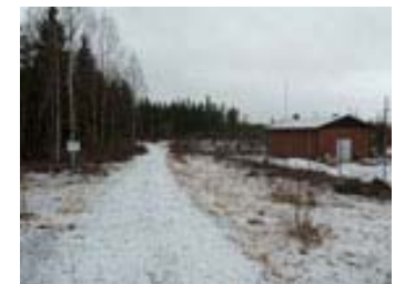
Spåret ligger i anslutning till ställverket på vägen till Oxberget.
